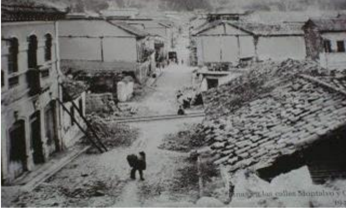
Imagen 3. Foto del terremoto de Ambato, paredes de piedra derrumbadas y casas de adobe en pie Fuente: Archivo Arq. Patricia Buenaño
